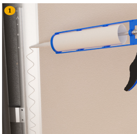
Applicering av LIP Skarvlim MSP på Våtrumskassetts fläns/sockel.
