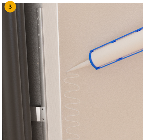
Applicera LIP Skarvlim MSP golv- och väggtytor som medföljande LK-förseglingsmaterial ska täcka. Sprid sedan ut limmet med en fintandad limspackel så limmet täcker hela ytan.
